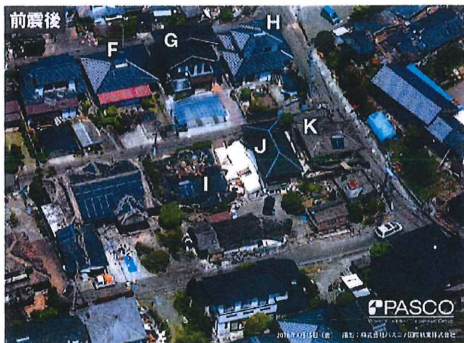
前震後の4月15日、益城町馬水地区の一角の様子。この時点で自立していたF、G、Hの住宅のうち、FとHは本震で倒壊した。I、J、Kの住宅は前震で大きな被害を受けた（写真：パスコ/国際航業）
