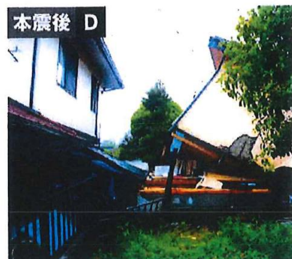
柱が引き抜け、転倒するようにして倒壊した（写真：日経ホームビルダー）
