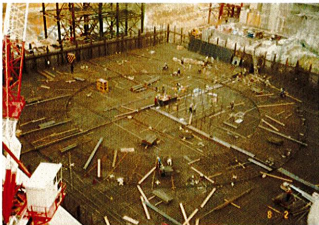
鉄筋の配置状況
