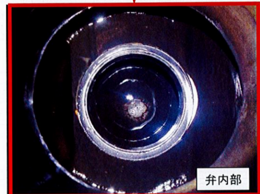
⑩－２ 水位制御弁 １次側配管内部
