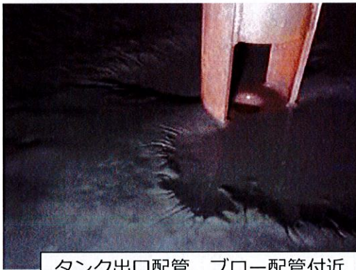
タンク出口配管、ブロー配管付近
