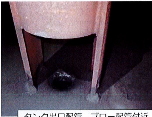
タンク出口配管、ブロー配管付近
