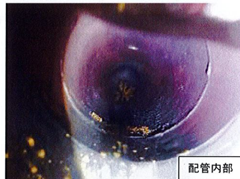
⑩－３ 水位制御弁 ２次側配管内部
