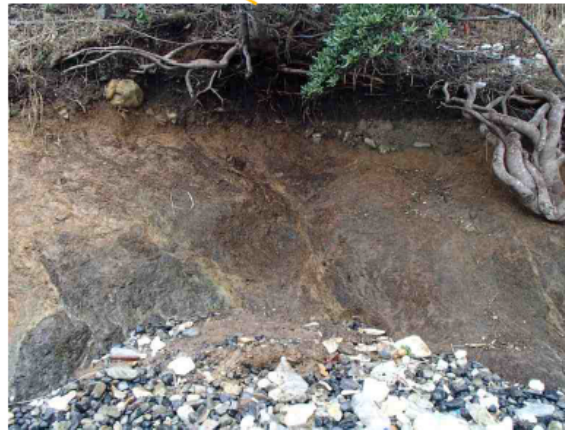
写真③: 関西電力が従来F-6としていた角礫状破碎帯
