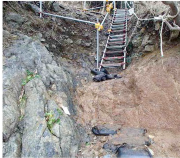
写真②:頁岩／超苦鉄質岩境界 角礫状破碎帯
