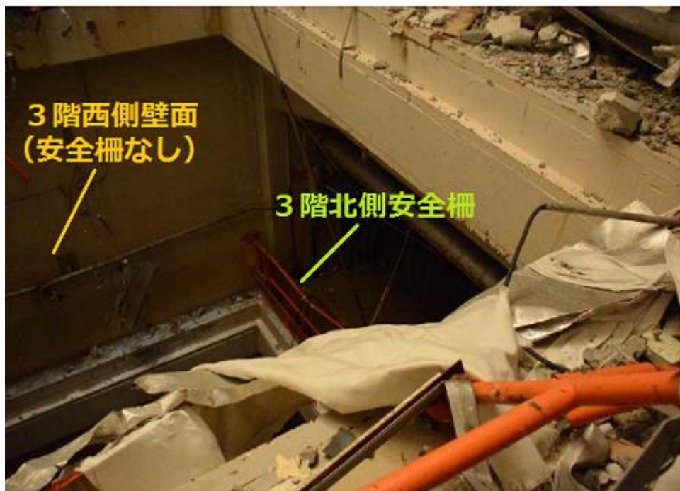
写真6：3階大物搬入口西側及び北側の状況（甲327「1号機4階における出水事象に関する現地調査結果について 11) 」25頁）
