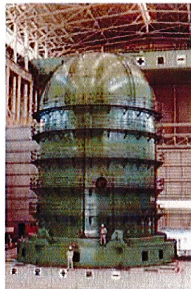
PWR原子炉格納容器 鋼製 〔縮尺:1/3.7, 重量:350㌧(実機:約3,800㌧)〕
